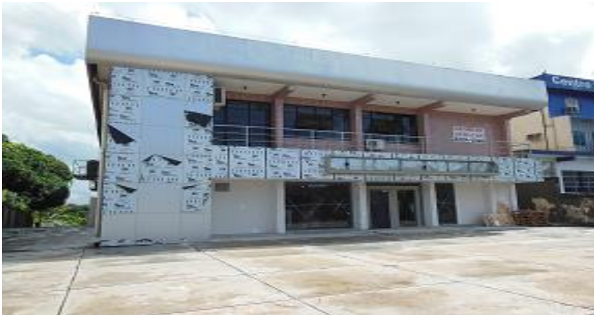
Figura 1 – Nova Sede do COREN-AM onde será realizado o serviço
