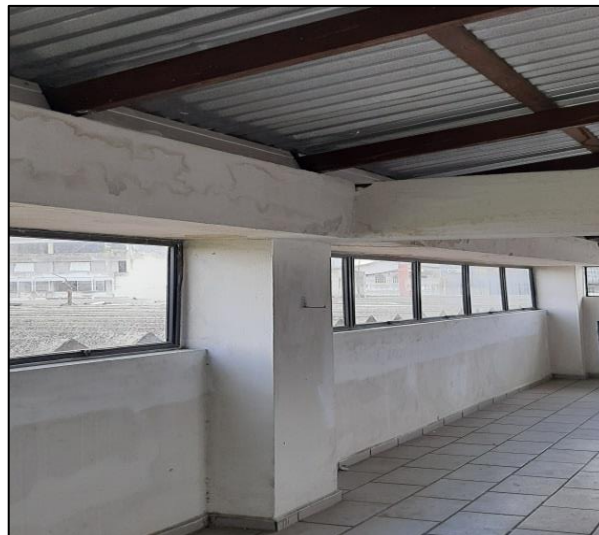
Fotos nº 28 e 29: imagens que ilustram local da caixa d'água e sinais/manchas de eflorescência nas paredes e vigas
