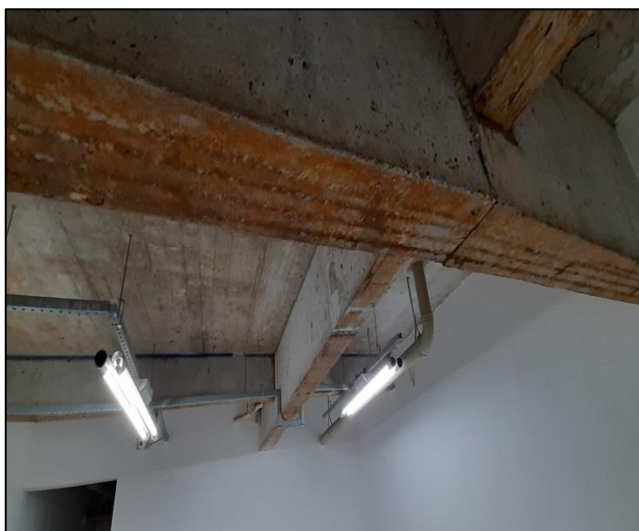
Figuras nº 19 e 20: imagens que ilustram sinais de oxidação das ferragens das vigas
