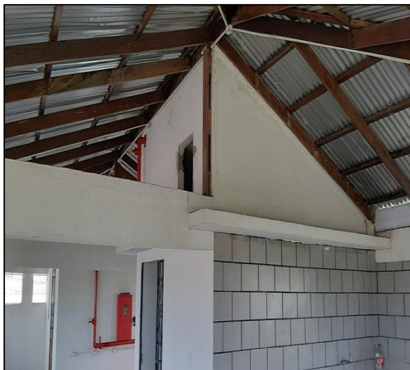
Fotos nº 28 e 29: imagens que ilustram local da caixa d'água e sinais/manchas de eflorescência nas paredes e vigas
