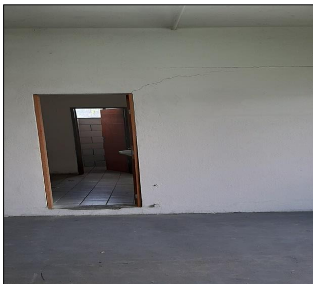
Figuras nº 26 e 27: imagens que ilustram fissura no vão da porta e entrada dos banheiros da edificação.
