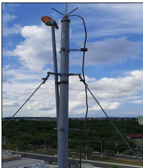
Figuras nº 13 e 14: imagens que ilustram haste Franklin (Sistema de proteção contra descargas atmosféricas) e posição do elevador e escada da edificação
