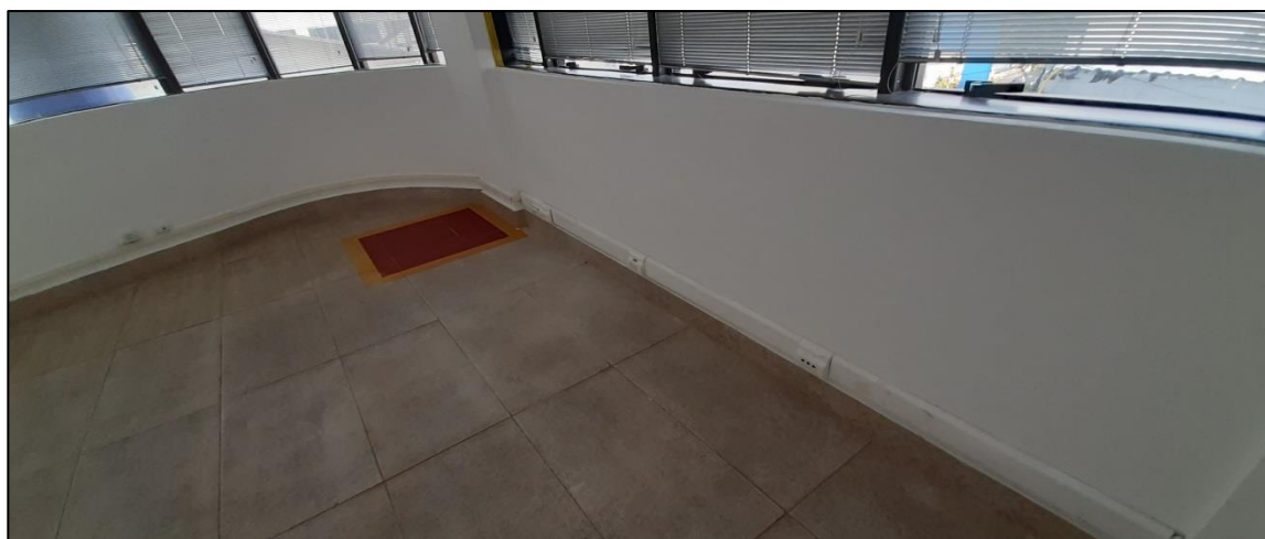
Figura nº 17: imagem que ilustra tipo de esquadrias e canaletas existentes na edificação
