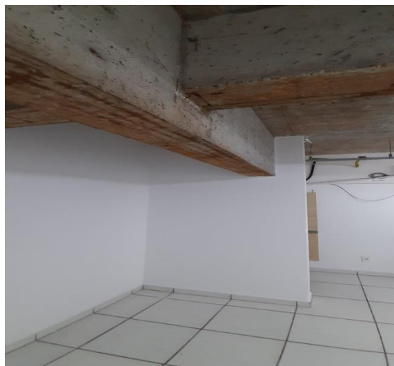
Figuras nº 19 e 20: imagens que ilustram sinais de oxidação das ferragens das vigas
