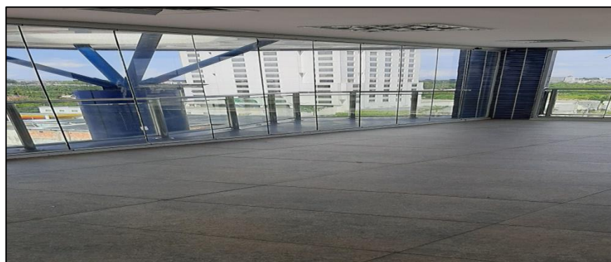
Figura nº 15: imagem que ilustra cobertura – último pavimento da edificação
